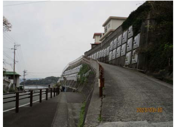
プレキャスト受圧版を使用したアンカー抑止工と横ボーリング工
