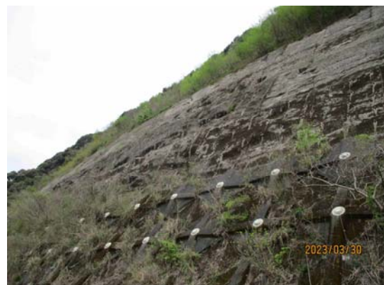
法面上部は鉄筋補強土工
