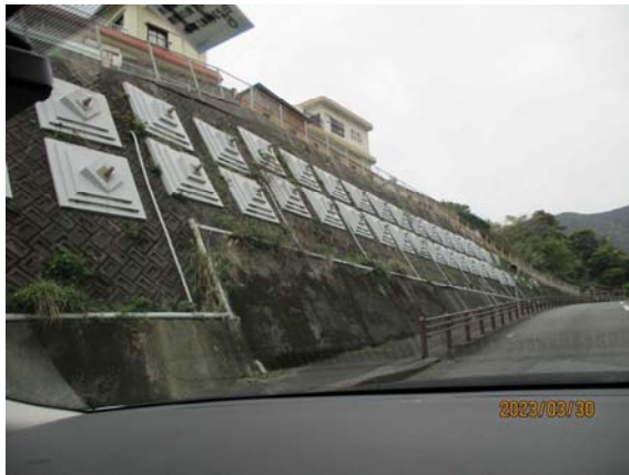
プレキャスト受圧版を使用したアンカー抑止工と横ボーリング工
