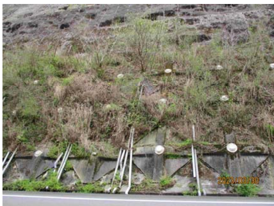
アンカー（プレキャスト受圧版）と横ボーリング群
